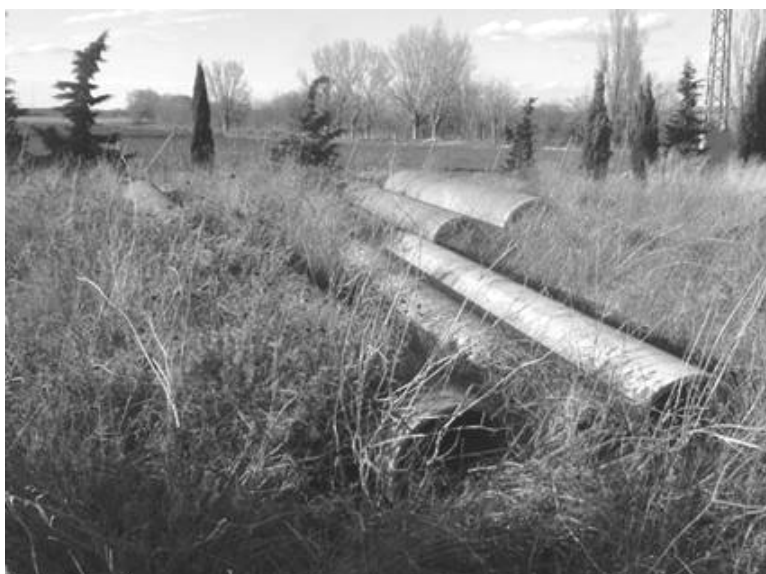
Tuberías fabricadas con fibrocemento abandonadas cerca de los depósitos de la Virgen de la Cabeza. (Tudela, Navarra). 5
