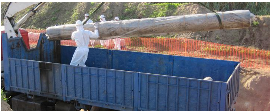
Retirada de tuberías de agua potable 10
