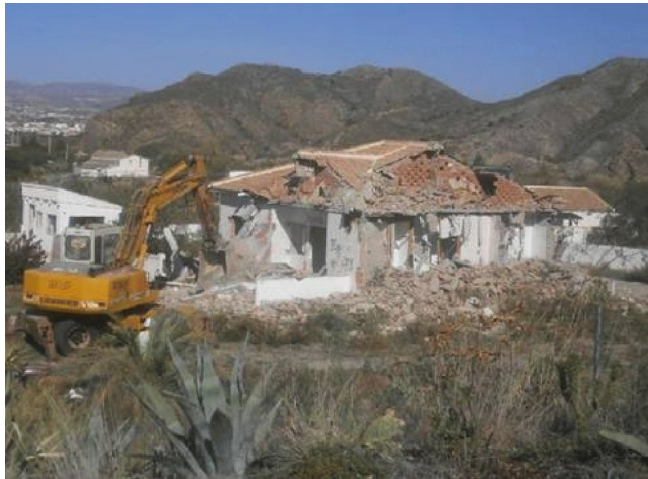
La demolición de viviendas ilegales es el mejor sistema de disuasión para futuras construcciones
