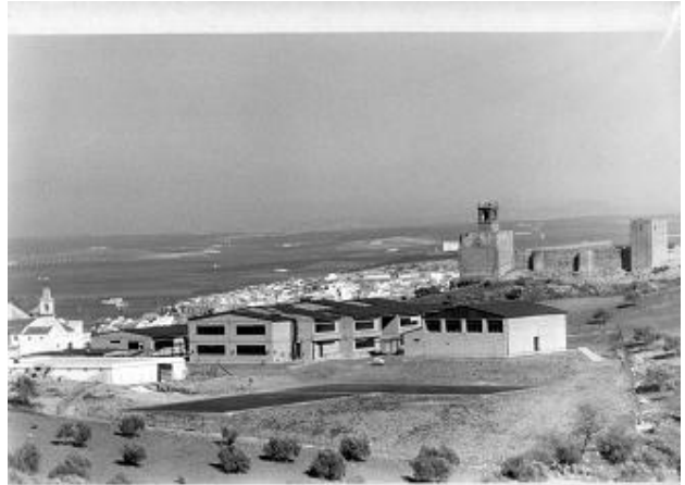
El CEIP San Juan recién construido. Fuente: web del colegio.
