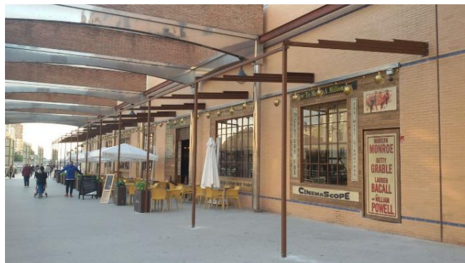
Figura 13 Pórticos principales de la estructura soporte
